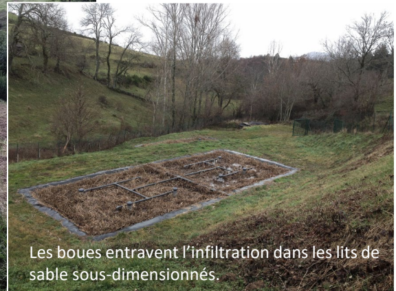
La station d'épuration du bourg est constituée de deux étages à filtres à sable plantés de roseaux.
