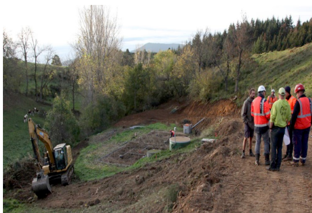
Démarrage du chantier le 2 novembre 2022.
