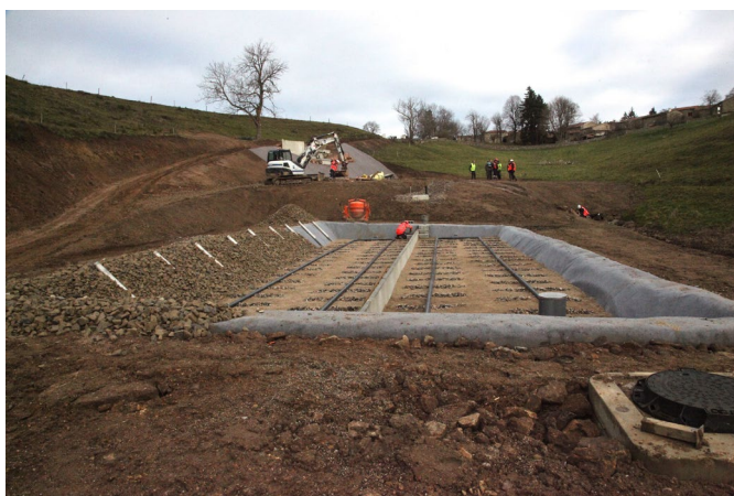
Janvier 2023. Pose des tuyaux de répartition sur les lits de sable du niveau inférieur. Pendant le temps des travaux, les eaux usées ont été traitées d'abord par l'ancien bassin inférieur, puis par le nouveau bassin supérieur. Les deux bassins neufs ont ensuite été raccordés.
