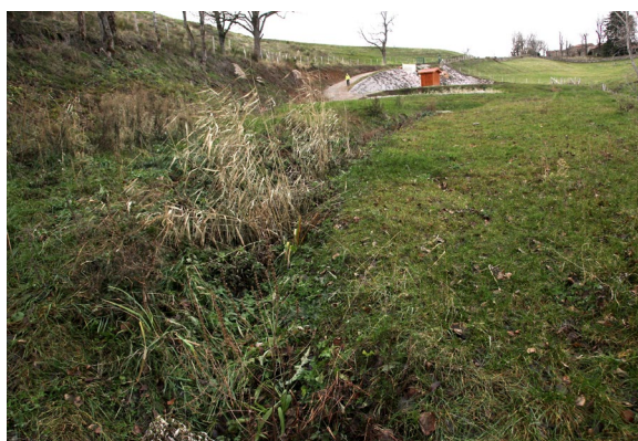
Le rejet final des deux lits d'épuration est infiltré dans un fossé enherbé planté d'iris et de roseaux.
