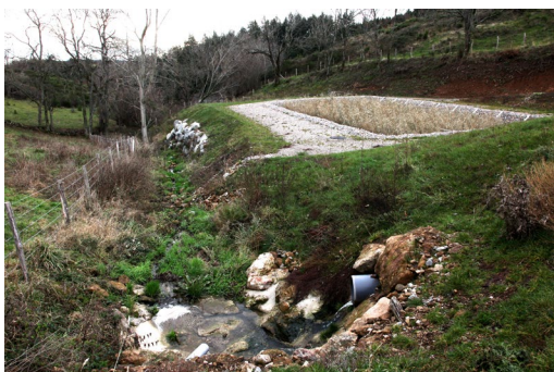
Talus enherbés et clôture agricole intègrent la station dans son environnement de pâtures. Les eaux pluviales et de drainage se déversent dans le ruisseau de la Masse en bordure de la station.
