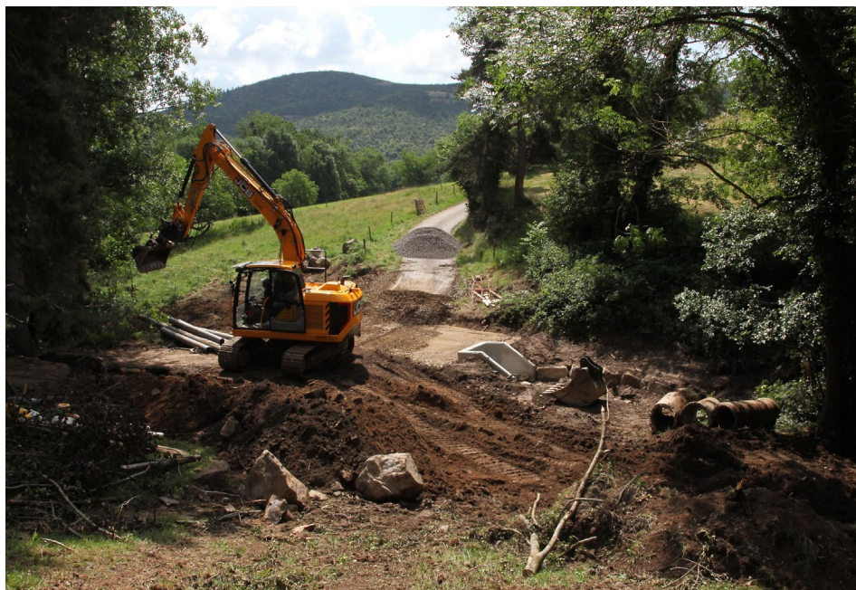
Fin de la mise en place des cadres préfabriqués du nouveau pont, avant la réfection de la chaussée. Les accotements élargis sécuriseront le virage pour les camions.
