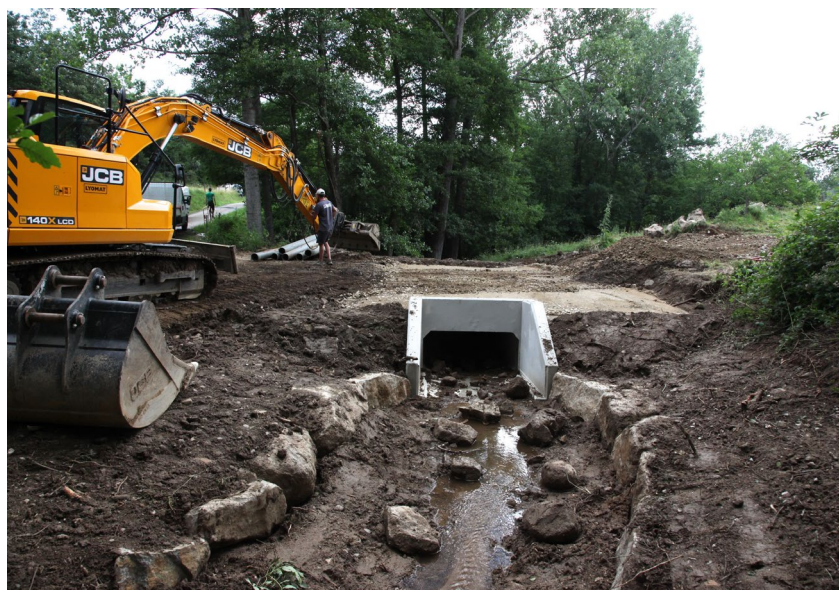
Les anciennes buses rondes ont été remplacées par un cadre rectangulaire permettant un plus fort débit en cas d'orage. Une cunette et un empierrement disséminé tout le long de la canalisation facilitent la circulation de la faune aquatique.
