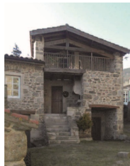
Exemple de débord de toiture
